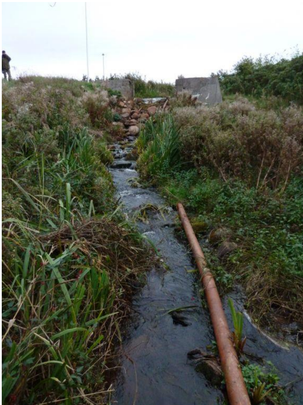
Figur 1.4 Spærring AAL-1128 set i opstrøms retning. Spærringen består af et stemmeværk med et efterfølgende stryg med et fald på 3,8 m over ca. 24 m
